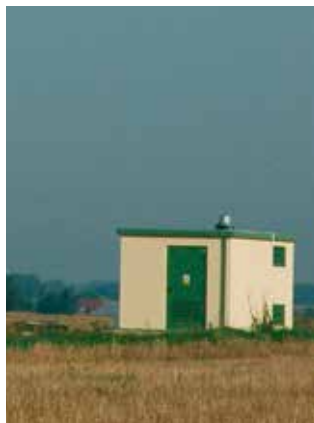
stacja transformatorowa 15/0,4 kV
